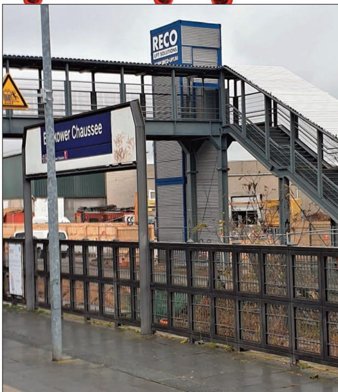
Bauarbeiten am S-Bahnhof Buckower Chaussee mit zusätzlichem Aufzug an der Treppenanlage.
