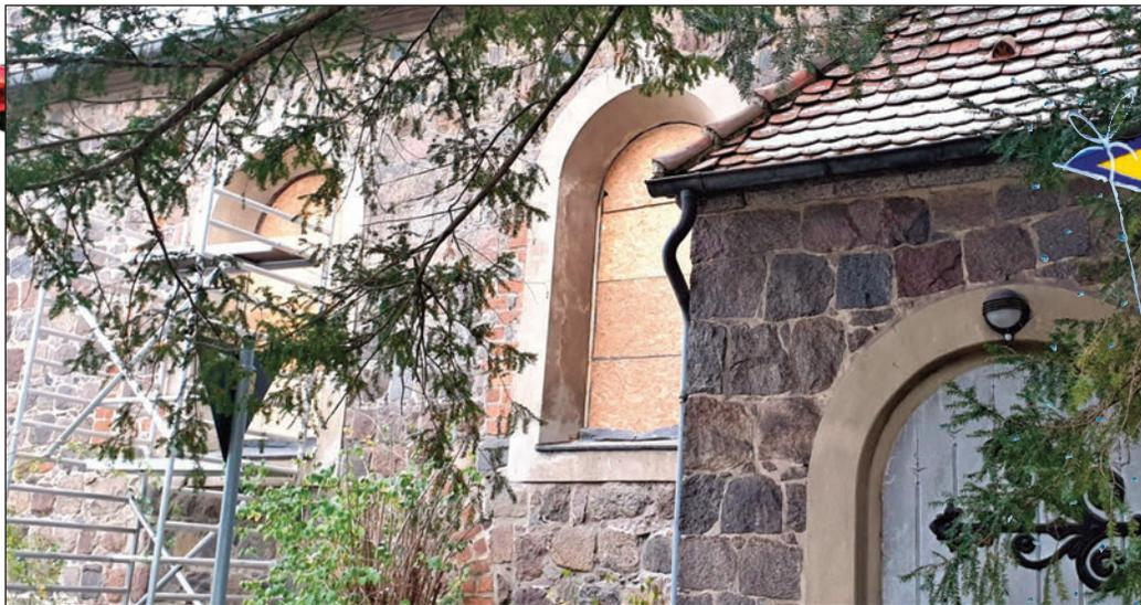
Drei von vier Fenstern an der Nordseite der Kirche werden im ersten Arbeitsschritt mit neuen isolierten Fenstern ausgestattet. Zum Schutz während der Arbeiten sind die Fenster mit Spanplatten isoliert.
